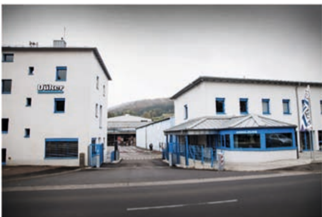
Fig. 1: Firma Düker i Laufach, Tyskland.
