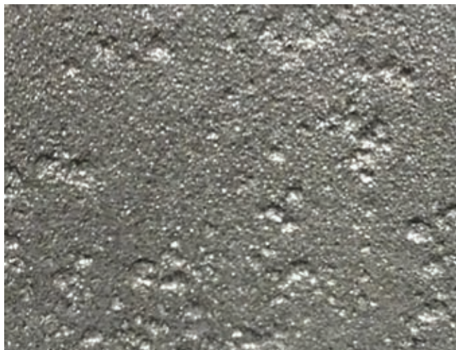
Fig. 2: Hvidbelægning, nærbillede
