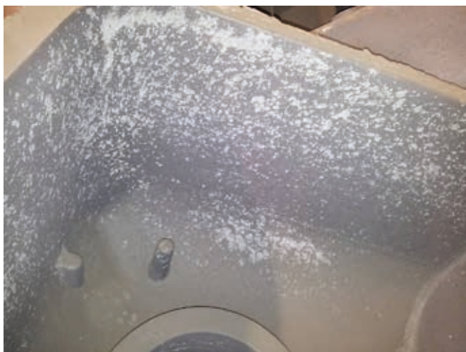
Fig. 1: Hvidbelægning på gearhus i SG-jern
